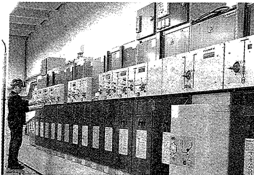
À Meaux, sur 1 300 agents, 400 sont des non-titulaires. La ville embauche des juristes, des urbanistes, des plombiers, des électriciens, des agents de cantine. BSIP
